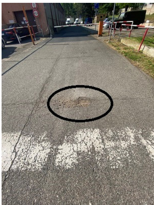
Obnovení vodorovného dopravního značení a oprava výtluku
