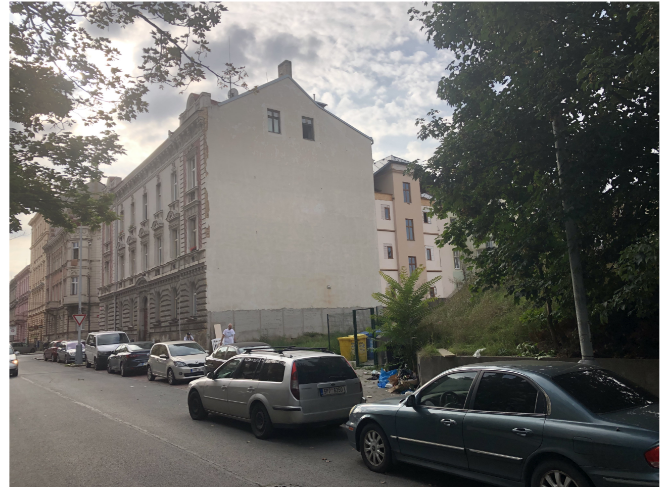
Foto sousedního objektu s okny ve štítu
