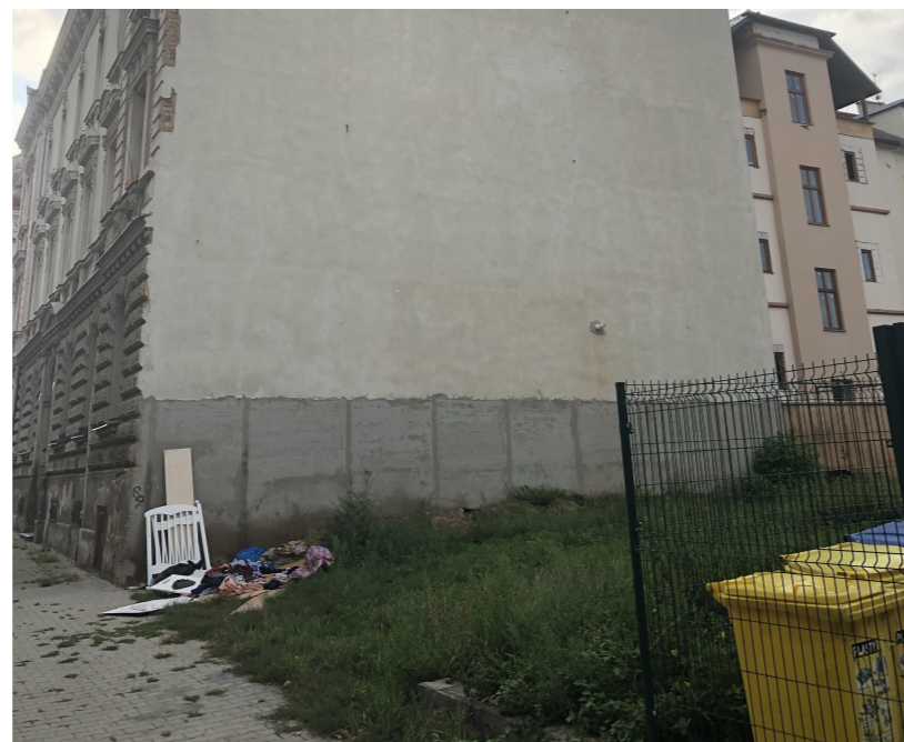
Foto stávající stav
