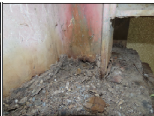
foto č. 1 - horní pásnice podélníku - vytlučené pod mostnicí foto č. 2 - vnější svislá výtzuha L. HL. N. nad O 01 - otvor
