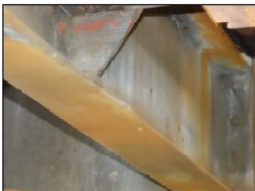
foto č. 11 - levý podélník dolní pásnice v 9. poli - deformace foto č. 12 - příčné ztužení podélníků v 9. poli - deformace
