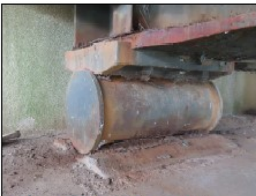
foto č. 14 - levé ložisko na O 02 - posunutý válec
