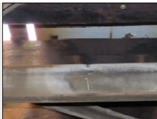
foto č. 11 - levý podélník dolní pásnice v 9. poli - deformace foto č. 12 - příčné ztužení podélníků v 9. poli - deformace
