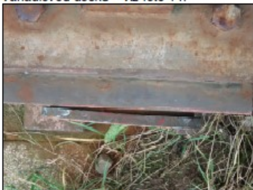
foto č. 13 - pravé ložisko na O 02 - zkřížení
