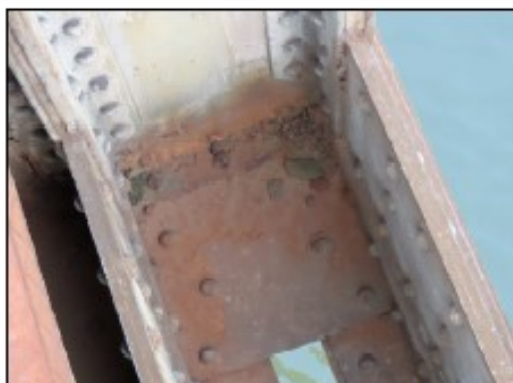
foto č. 3 - P. HL. N. napojení na 10. svislici - oslabení
