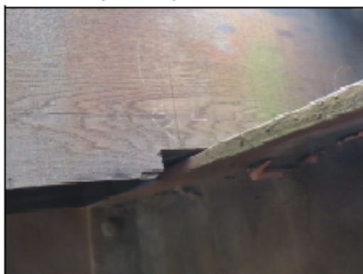
foto č. 1 - horní pásnice podélníku - vytlučené pod mostnicí foto č. 2 - vnější svislá výtzuha L. HL. N. nad O 01 - otvor
