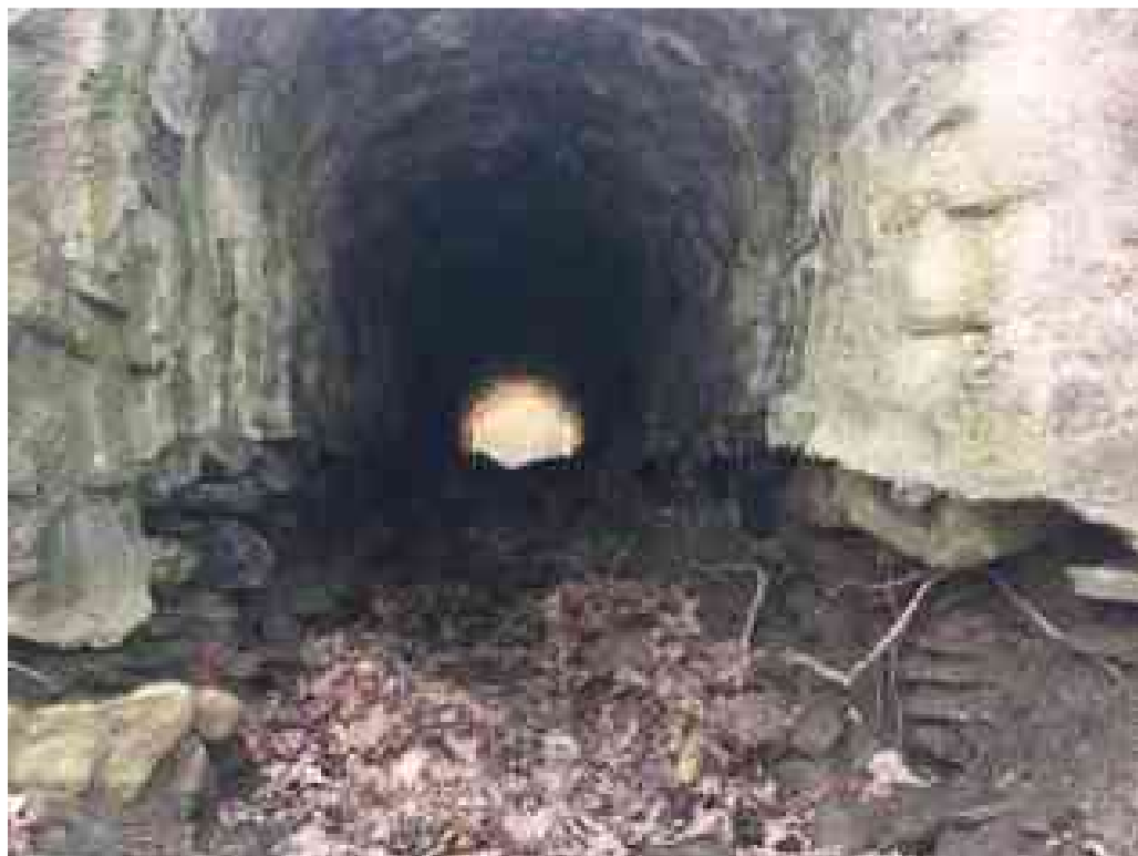
Obr. 1 Propustek 01 – pohled od severu na jih
