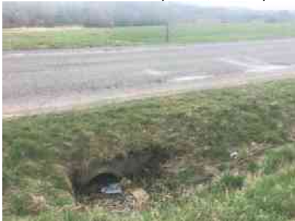
Obr. 3 Propustek 06 – pohled na vtok
