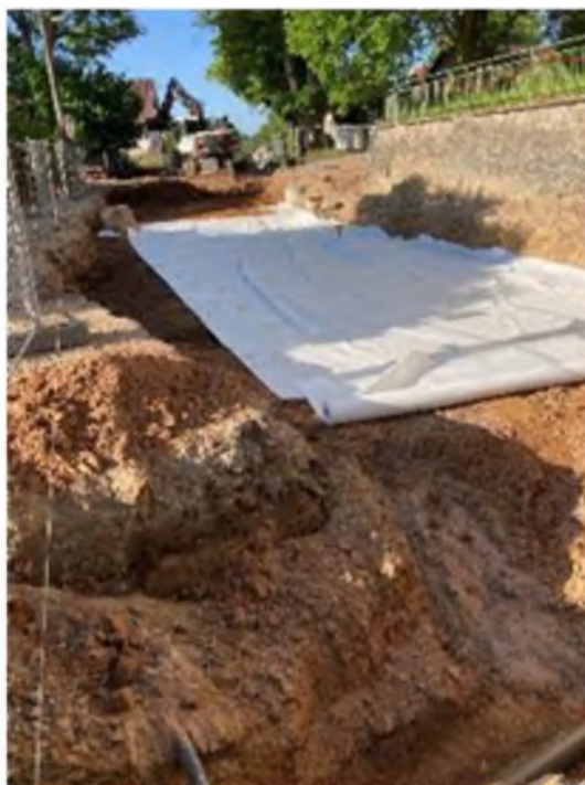
Pokládka geotextílií
