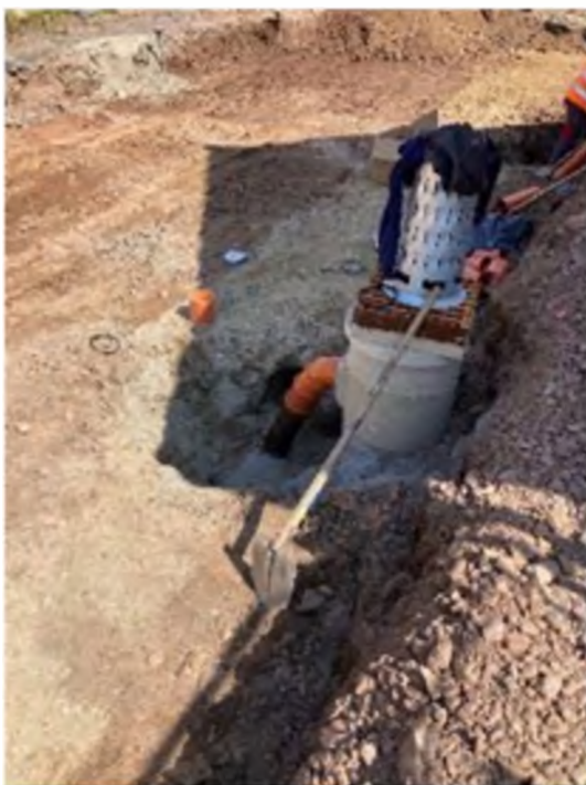
Napojení UV a dešťových svodů
