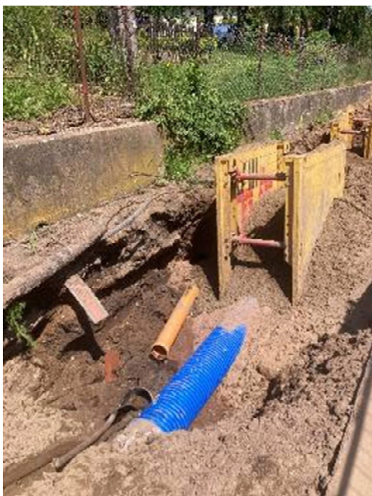
Dešťová kanalizace stoka „E1“
