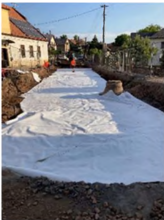
Pokládka geotextílií
