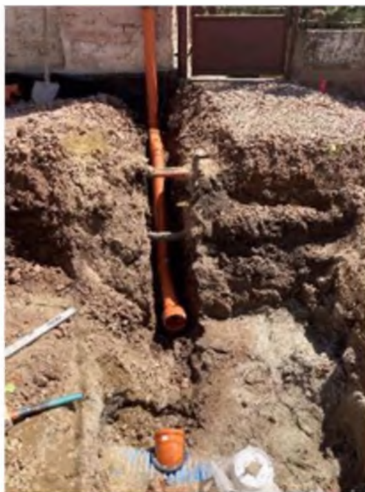
Napojení UV a dešťových svodů
