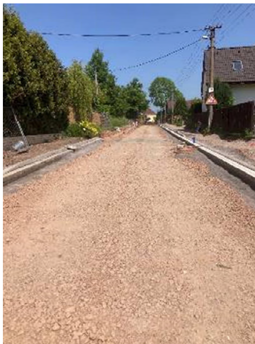
Pokládka silničních obrub do betonového lože
