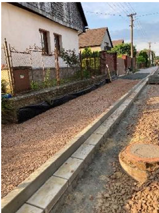
Pokládka silničních obrub do betonového lože
