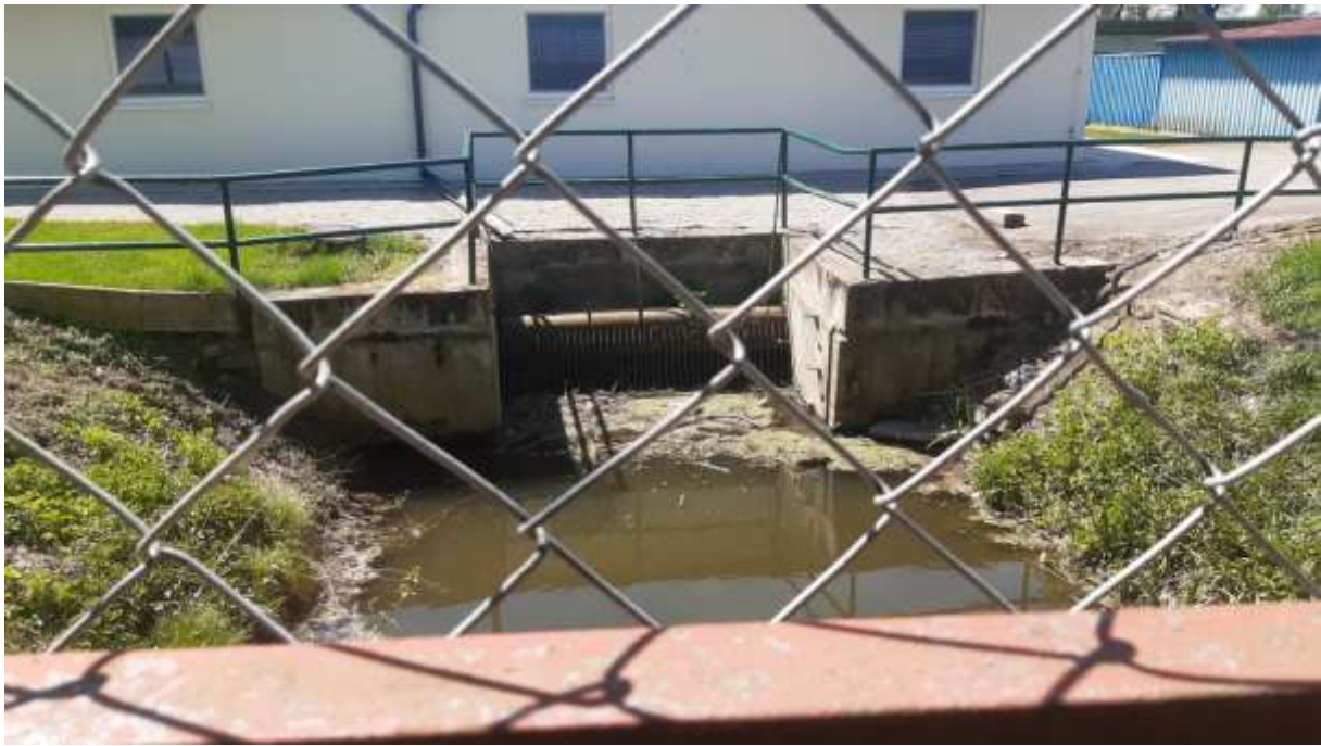
Obr. č. 13: Větev pokračující rovně zaklenuta pod sportovní areál, na ústí osazena dlužová stěna
