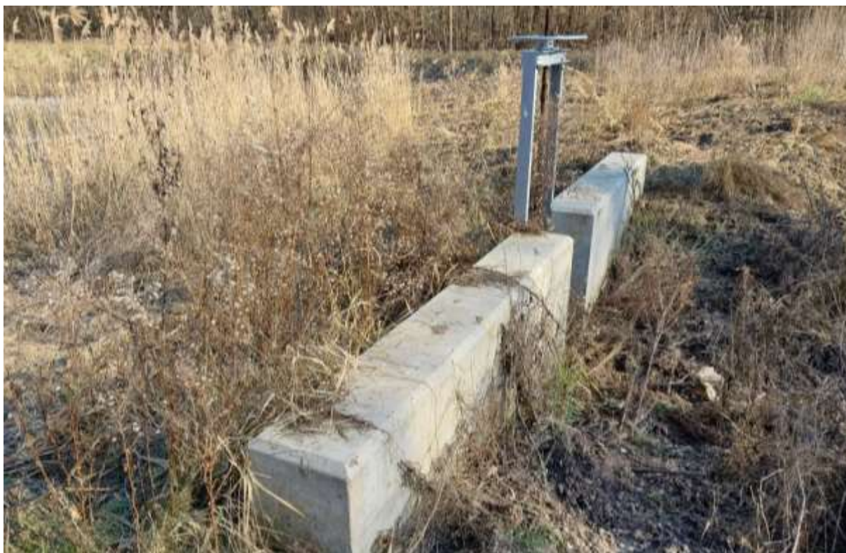
Obr. č. 17: Stavítko na vodní ploše Štoglovka
