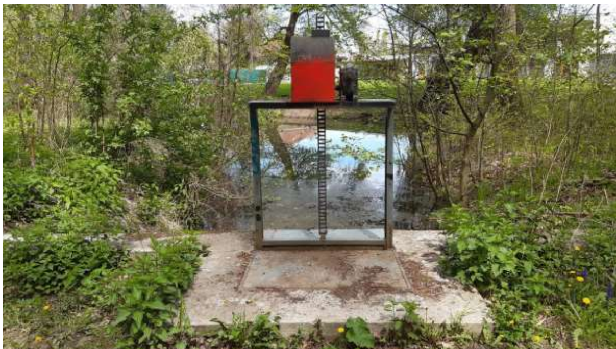
Obr. č. 3: Manipulační objekt (stavitko s propustem) na VT Pivovarský járek, v ř. km 4,123 Mlýnského náhonu
