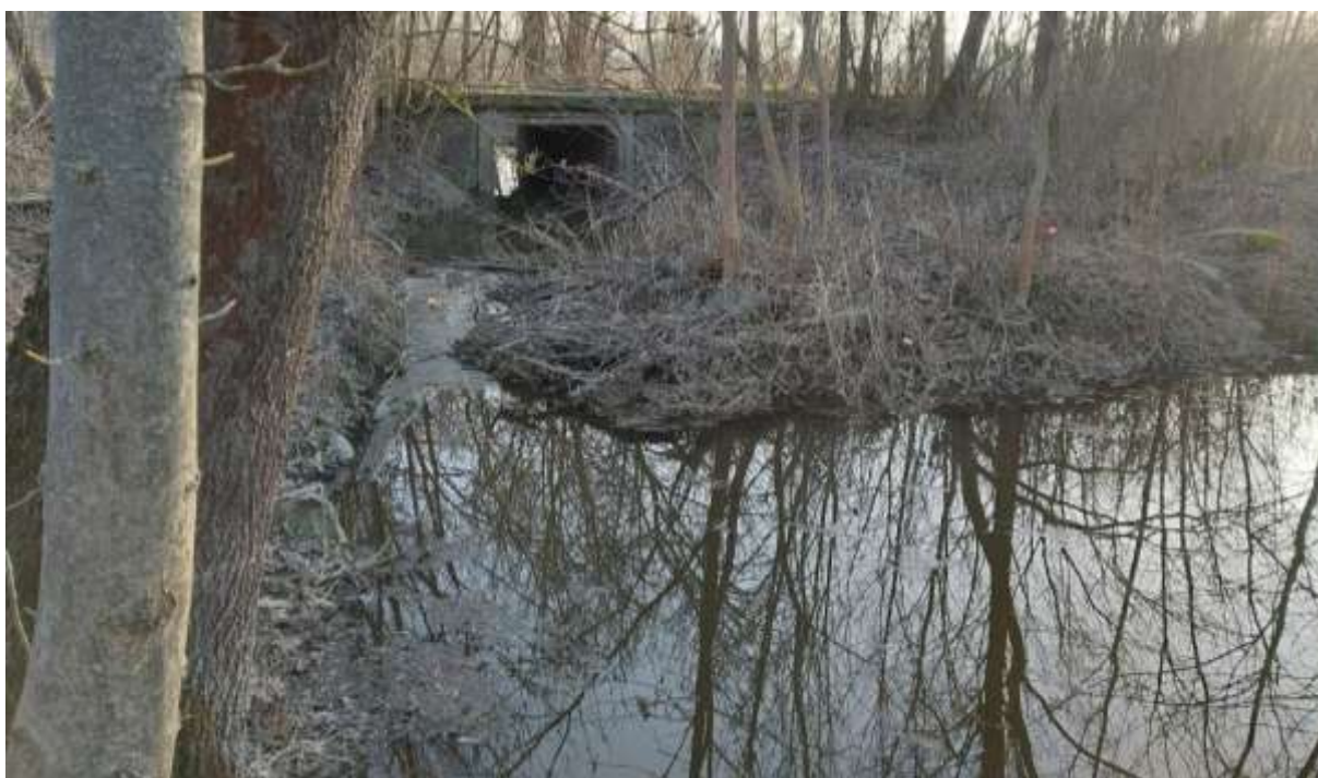
Obr. č. 20: Přírodní val v minulosti uměle vybudován za účelem vzdutí vody, za ním propustek v ř. km 0,4 - teoretická možnost předsazení stavítka/dlužové stěny
