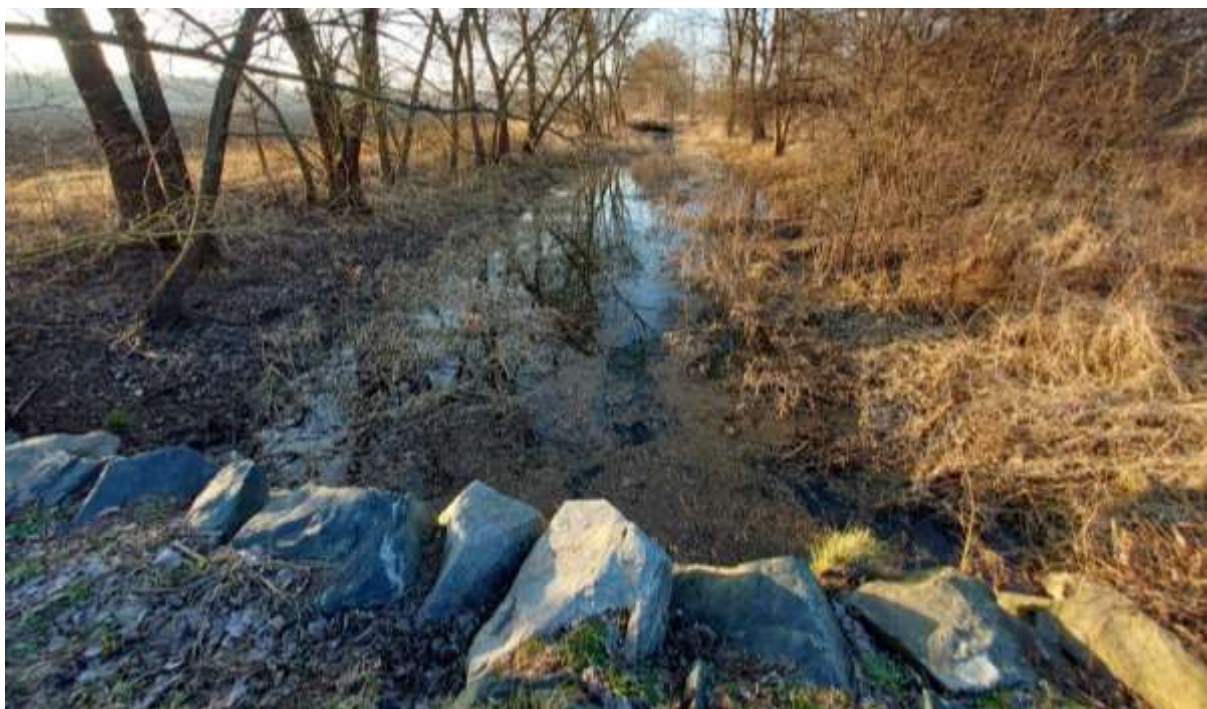
Obr. č. 21: Pohled z proti proudu z propustky před vyústěním do Dyje
