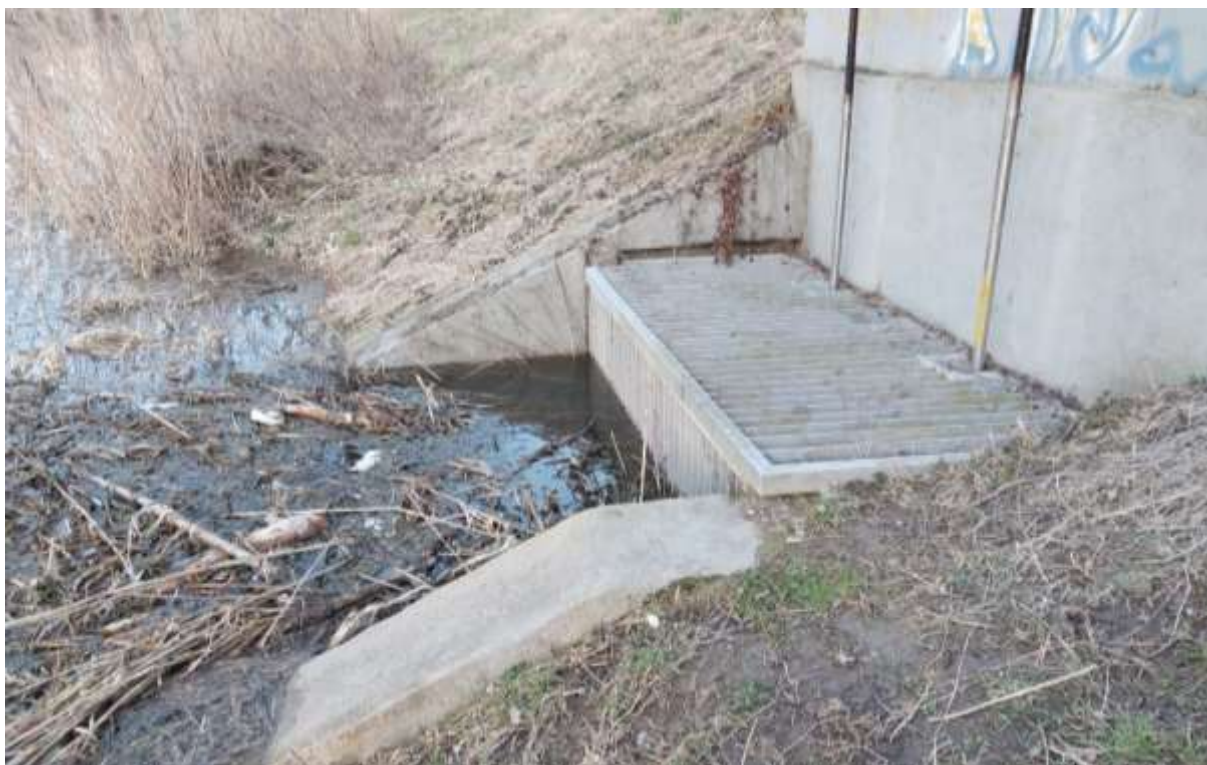
Obr. č. 1: Manipulační objekt v ř. km 4,128 odlehčovacího ramene Dyje
