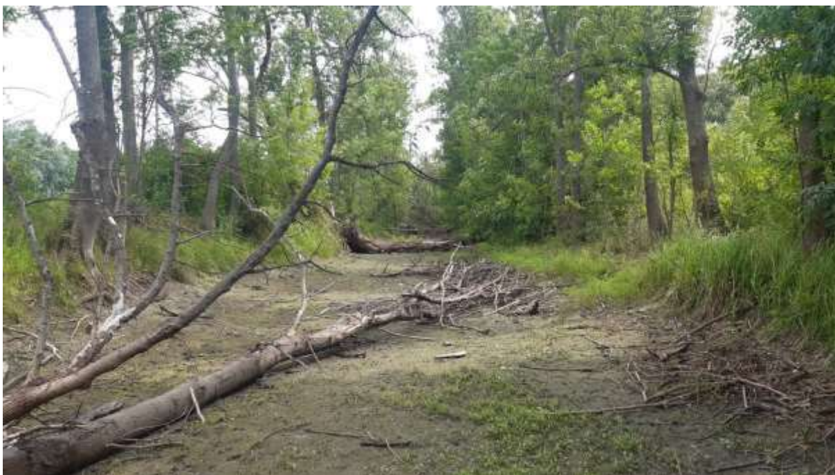
Obr. č. 19: Úsek VT v lesním porostu, vlivem malých odběrných množství, neefektivního dělení průtoků a zanesení dílčích úseků VT sedimentem úsek mezi ř. km 0,0 – 0,7 je v letních měsících zcela bez vody
