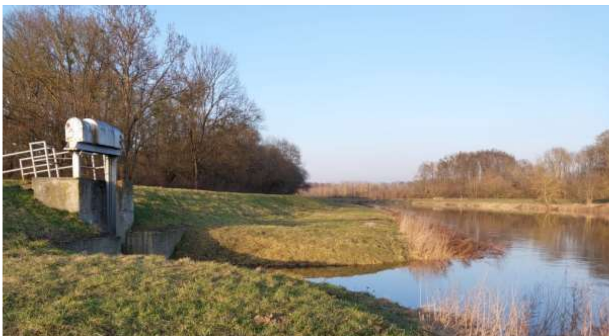
Obr. č. 22: Manipulační objekt PMo při vyústění do Dyje
