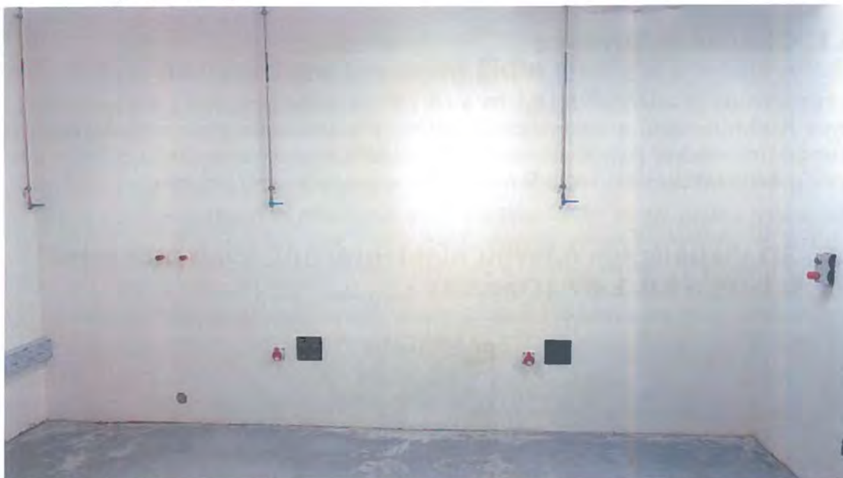
Obr.11 - Jižní stěna laboratoře ChemLAB LB.1.12 (stav k 4. prosinci 2015).
