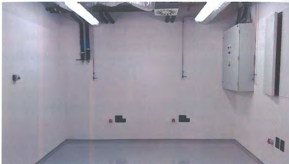
Obr.9 - Severní stěna laboratoře ChemLAB LB.1.12 (stav k 29. březnu 2016).
