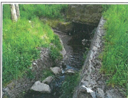
Vtok do propustku
