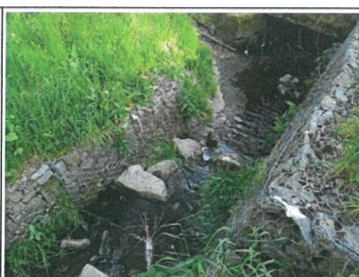
Vtok do propustku
