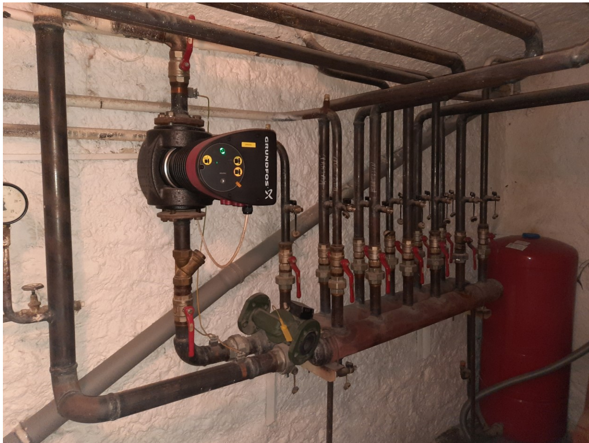
Obr. 3 – rozdělovač a sběrač v 1.PP
