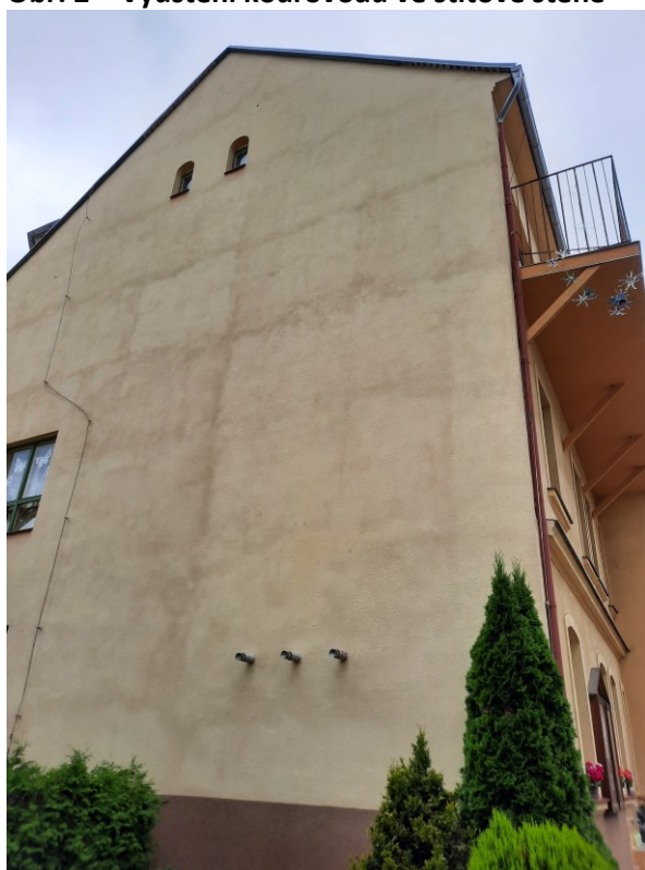
Obr. 2 – Vyústění kouřovodů ve štítové stěně
