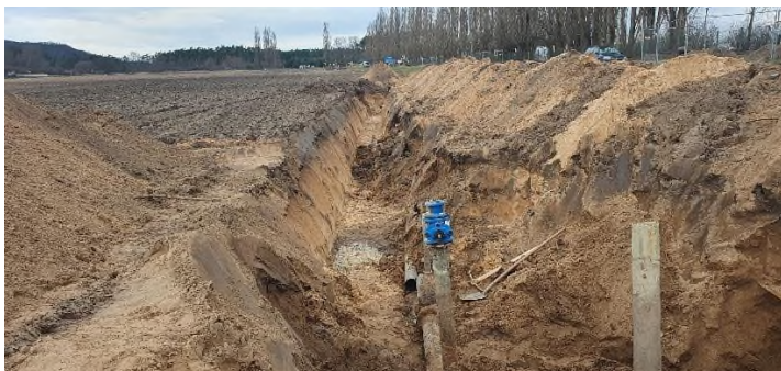
Výkop pro SO 311 v km cca 0,4 až 0,45
