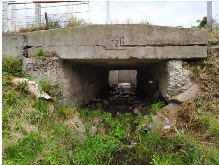
Prostorové uspořádání pod mostem (povodní)
