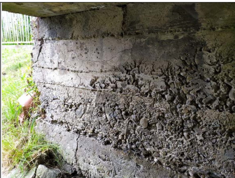
Pohled na opěru 2
