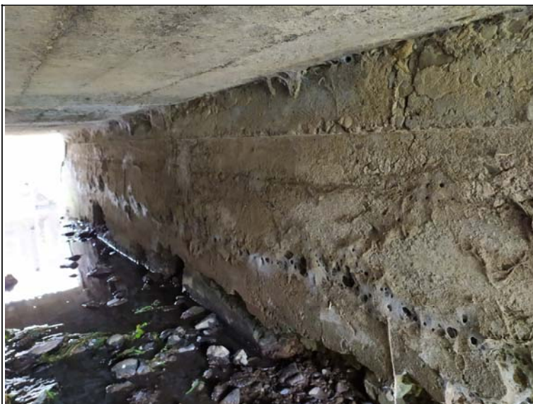
Pohled na opěru 1
