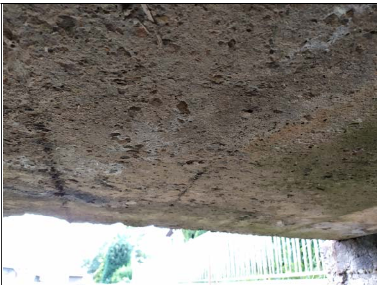
Podhled nosné konstrukce
