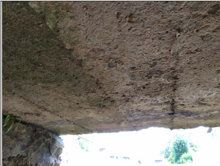
Podhled nosné konstrukce
