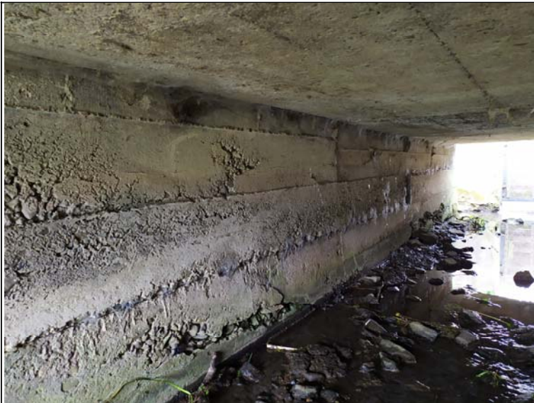
Pohled na opěru 2
