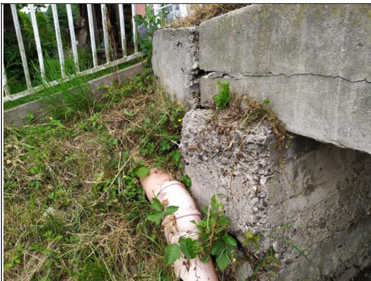
Pohled na levé křídlo opěry 2
