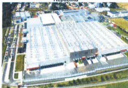
Projektové řízení, technický dozor, kontrola nákladů a BOZP novostavby a rozšíření výrobního závodu LEGO, Kladno, Česká Republika
