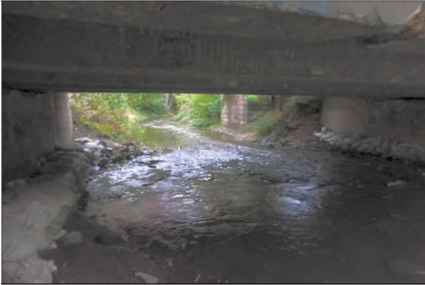
Průhled mostním otvorem.
