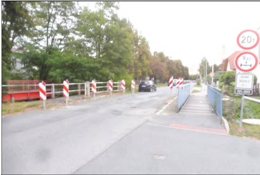
Pohled na most po směru staničení.
