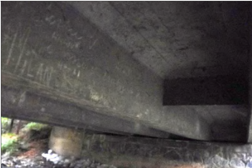
Pohled na spodek nosné konstrukce.
