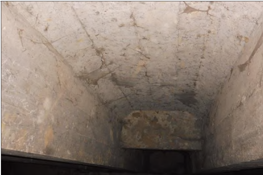
Pohled na spodek nosné konstrukce.
