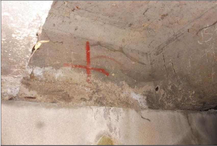
Pohled na spodek nosné konstrukce.
