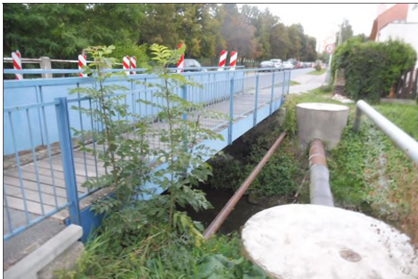
Pohled na most zprava.
