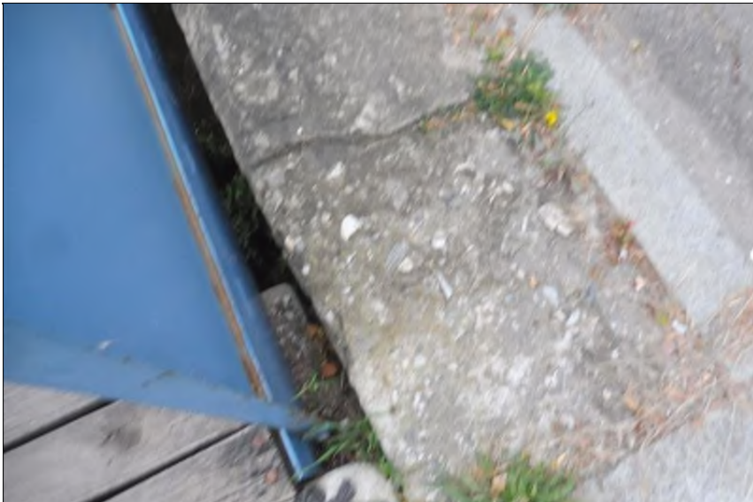
Trhlina v římse.
