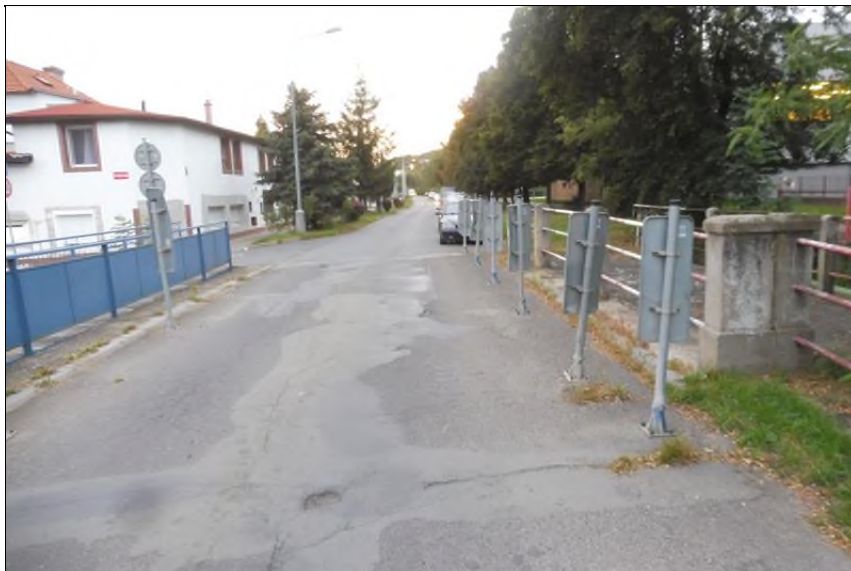
Pohled na most proti směru staničení.
