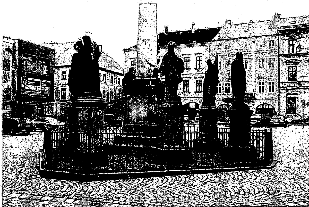
Sloup Nejsvětější Trojice se sochou Panny Marie (morový sloup), Rumburk, číslo rejstříku ÚSKP: 18233/5-3875 - pohled na poškozený sloup, před zahájením restaurování
