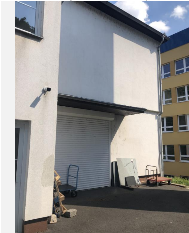
Obr. 6 FOTO Vjezd do zkušební haly
