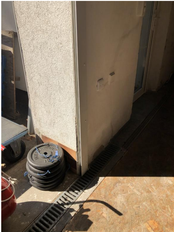
Obr. 16 FOTO odtokový žlábek vjezd
