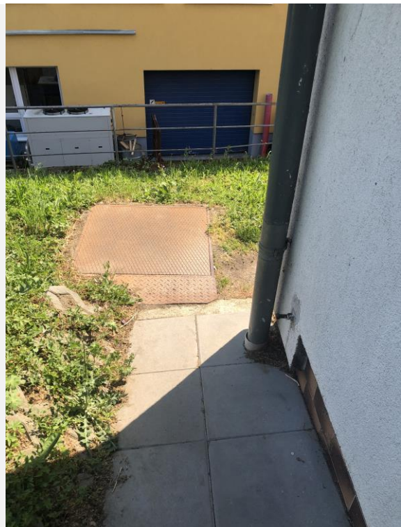
Obr. 11 FOTO Šachta pro dešťové srážky
