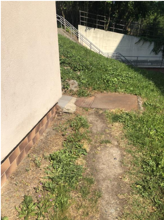
Obr. 8 FOTO Jižní fasáda, šachta pro dešťové srážky
