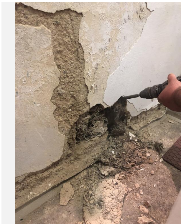
Obr. 12 FOTO Interiér zkušební haly vlhkostní poruchy – sondy vnitřní zateplení
