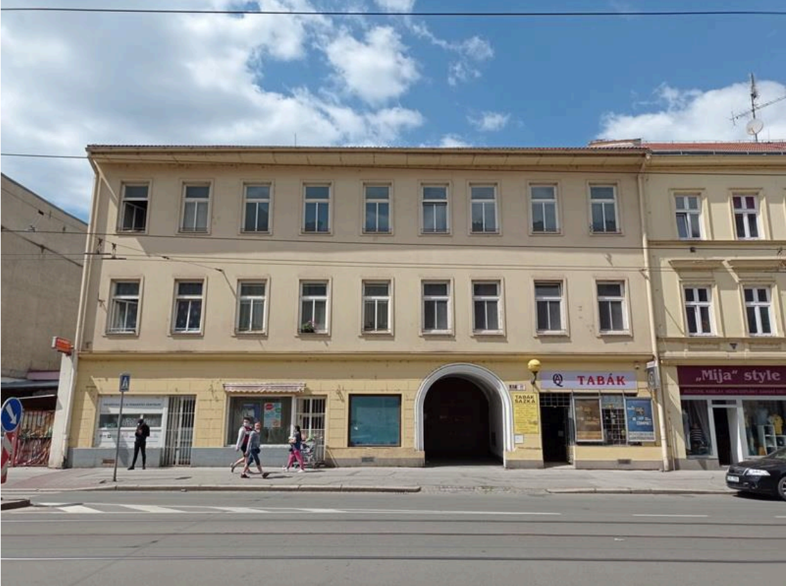
Čelní pohled s průjezdem:
