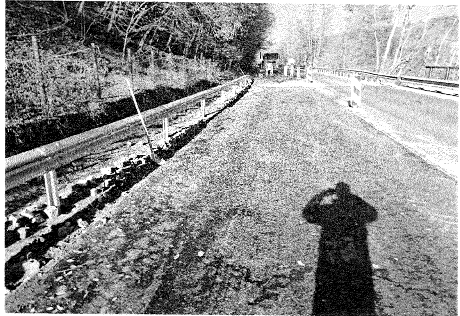
OPRAVA KRAJNÍHO DLAŽ KOSTKY - VPRAVO KM 13,250
