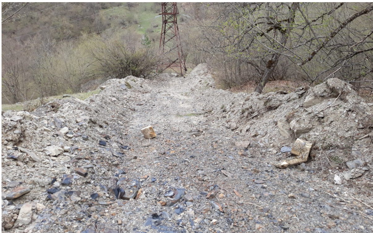
Obrázek 3 Nevhodně řešené zpřístupnění porostu, které vzniklo prodloužením nezpevněné cesty vedoucí ke stožáru nadzemního elektrického vedení. Cesta vedená po spádnicí je bránou k hlubokým erozním rýhám až sesuvům půdy. Okolí vesnice Barisakho, duben 2019.
