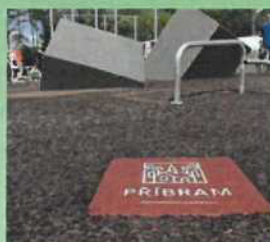
Pro zvýšení odolnosti povrchu jsou exponovaná místa vyztužena pryžovou dlaždicí (výjezd ze skluzavky, pod houpačkami, ...)
