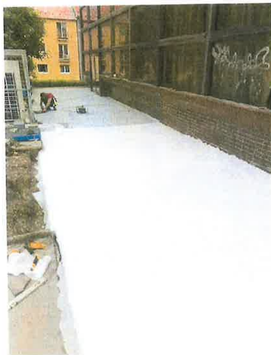
Ochranná vrstva z geotex. pod PVC
