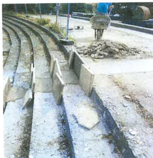
Betonáž st. schodiště
