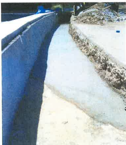
Dobetonávka stávající kee,
