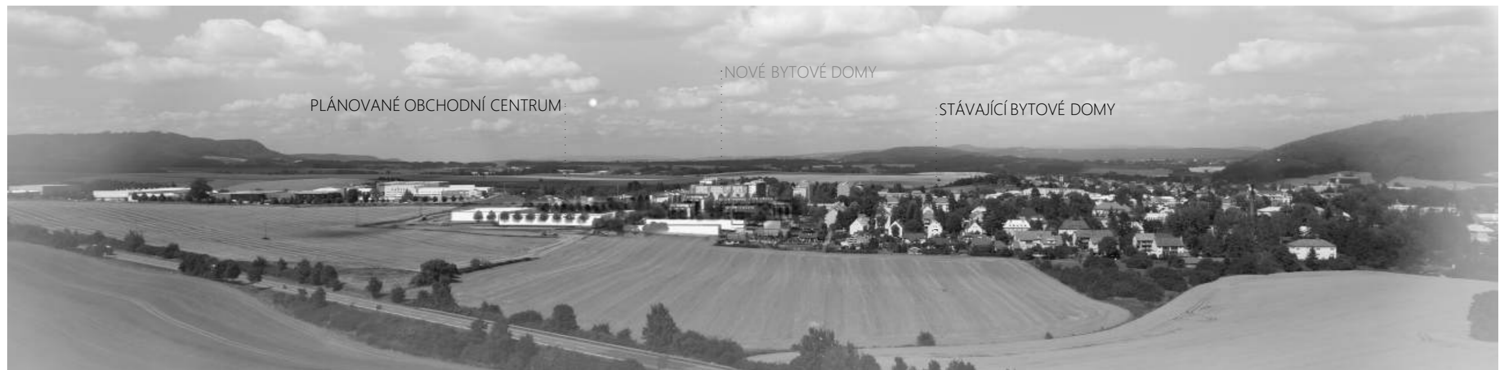
POHLED OD MOSTU K ROZVODNĚ
