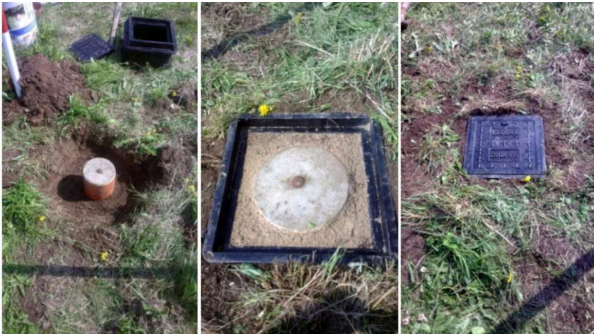
Obrázek 41 Příklad řešení plastové šachty hranaté
