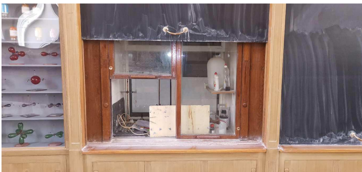
3x digestoř + tabule – dveře digestořů repase + zprovoznění, tabule 1,5x1,5m repase, nátěr, zprovoznění, výměna kování
