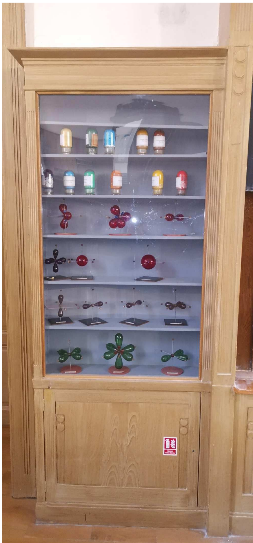
Vitrína – 2x 1mx2,8m – nátěr, doplnění otevírání (panty, zámek)
