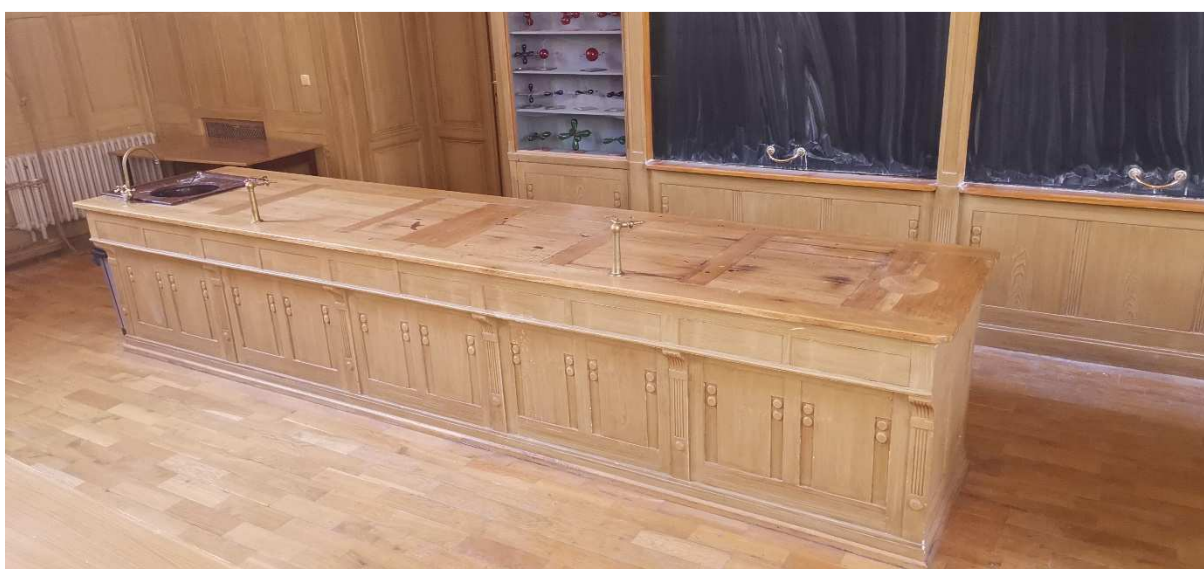
Katedra – 2x 1m x 4,5m – nový nátěr, nová pracovní deska, oprava zprovoznění dvířek
