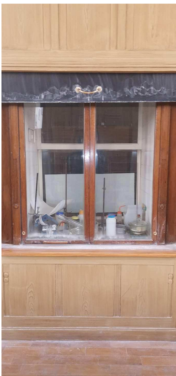
3x digestoř + tabule – dveře digestořů repase + zprovoznění, tabule 1,5x1,5m repase, nátěr, zprovoznění, výměna kování
