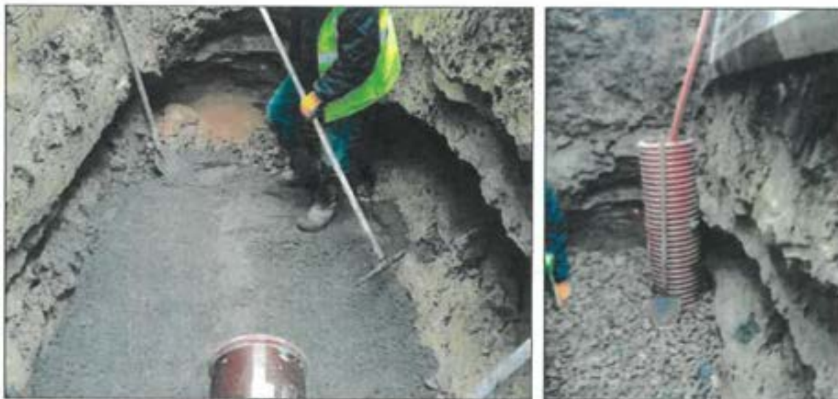
Obr. č. 1 a 2: výkop a sanace báze rýhy stoky C
