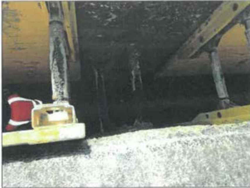
Obr. č. 3: výkop stoky A1
