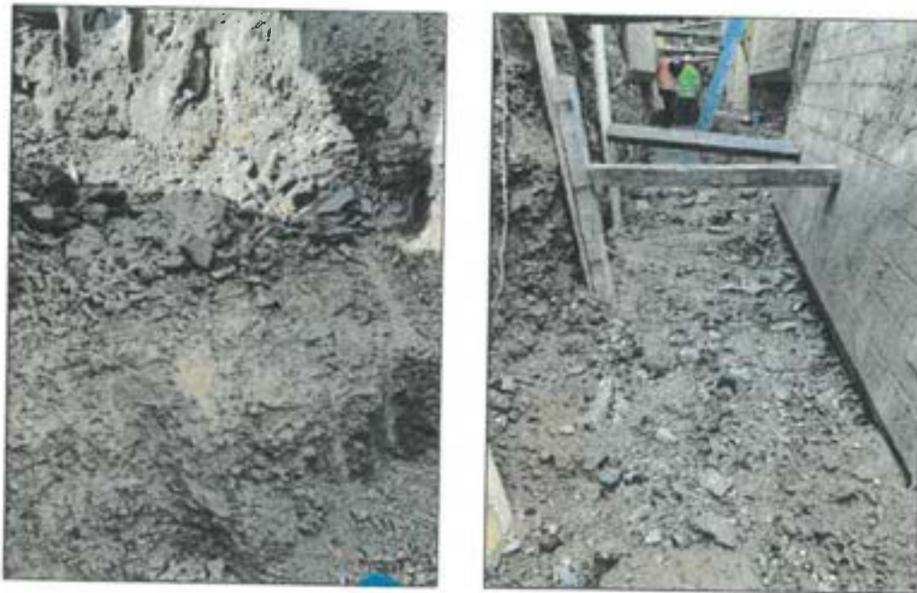
Obr. č. 1 a 2: výkop stoky A
