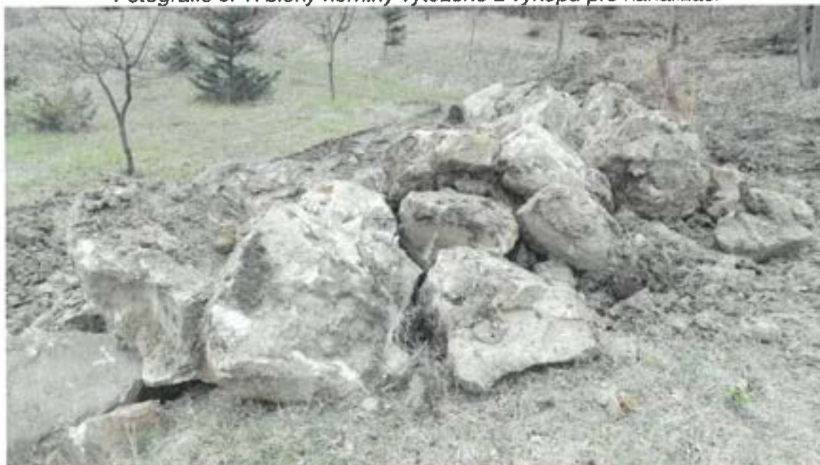
Fotografie č. 1: bloky horniny vytěžené z výkopu pro kanalizaci
