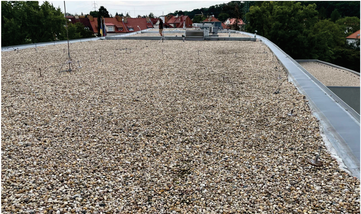
Střecha objektu B
