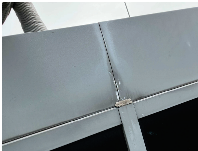
Obr. 2 - Čelní pohled na atiku – fasádní plech
