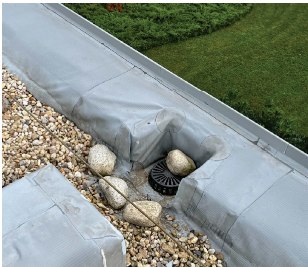
Obr. 1 - Střešní pohled na atiku
