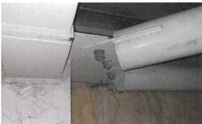
OBR: C, D – Stále uvolněné šrouby
