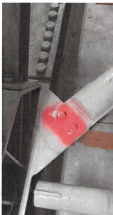
OBR: 17 – Dlouhé otvory v přípajích výpletu
