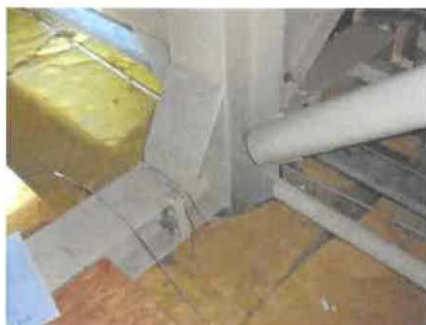
OBR: 18, 19, 20 – Deformace styčnickového plechu podélného vertikálního ztužidla – BEZE ZMĚNY OD MINULÉ KONTROLY
