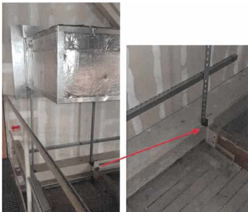
OBR: 26, 27 – Vyosená podpora potrubí VZT – 07/2021
