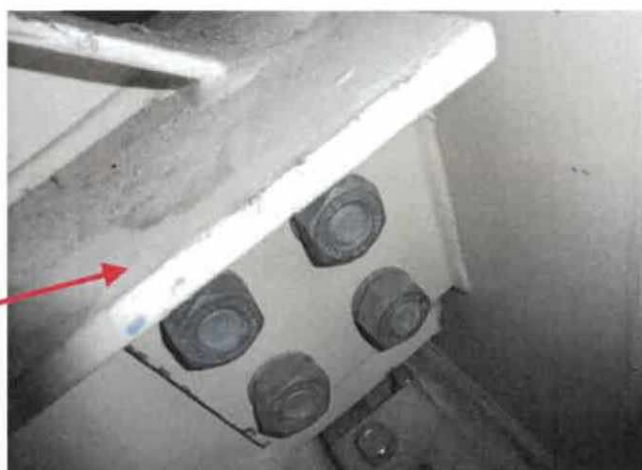
OBR: 08, 09 – Všechny volné šrouby v přípojích – BEZE ZMĚNY OD MINULÉ KONTROLY
