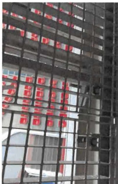
OBR: E – Uvolněné přichytky pororoštu – 04 / 2023
