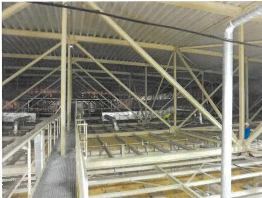
OBR: 03 – Pohled do konstrukce střechy Budvar arény
