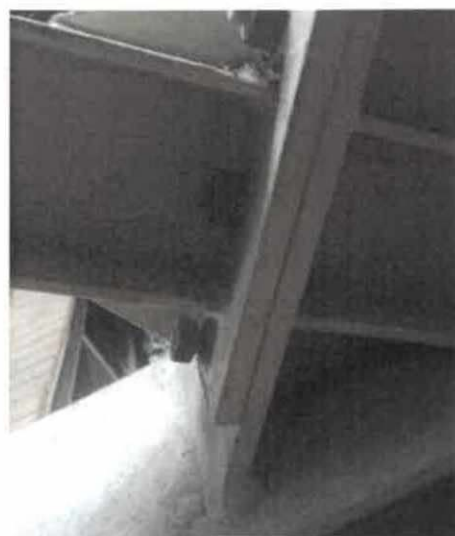
OBR: 08, 09 – Všechny volné šrouby v přípojích – BEZE ZMĚNY OD MINULÉ KONTROLY
