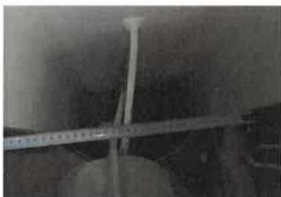
OBR: 18, 19, 20 – Deformace styčnickového plechu podélného vertikálního ztužidla – BEZE ZMĚNY OD MINULÉ KONTROLY
