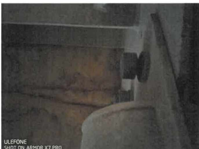
OBR: 08, 09 – Všechny volné šrouby v přípojích – BEZE ZMĚNY OD MINULÉ KONTROLY
