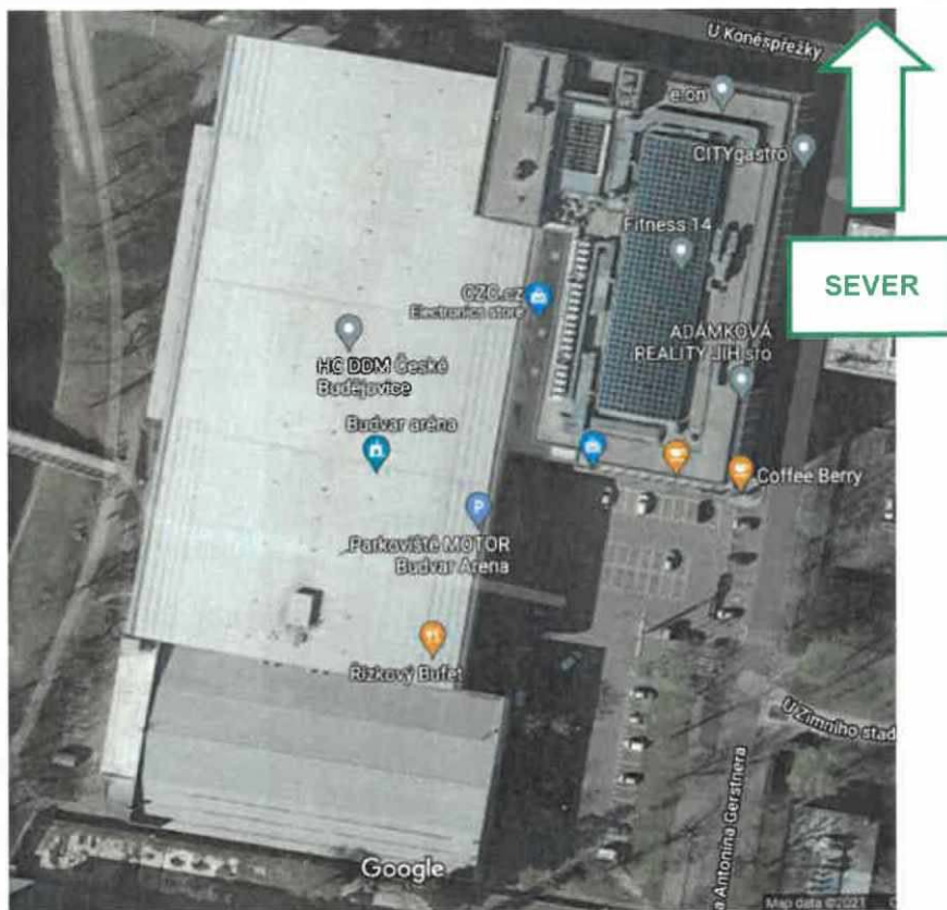
OBR: 02 – Letecký pohled na konstrukci
