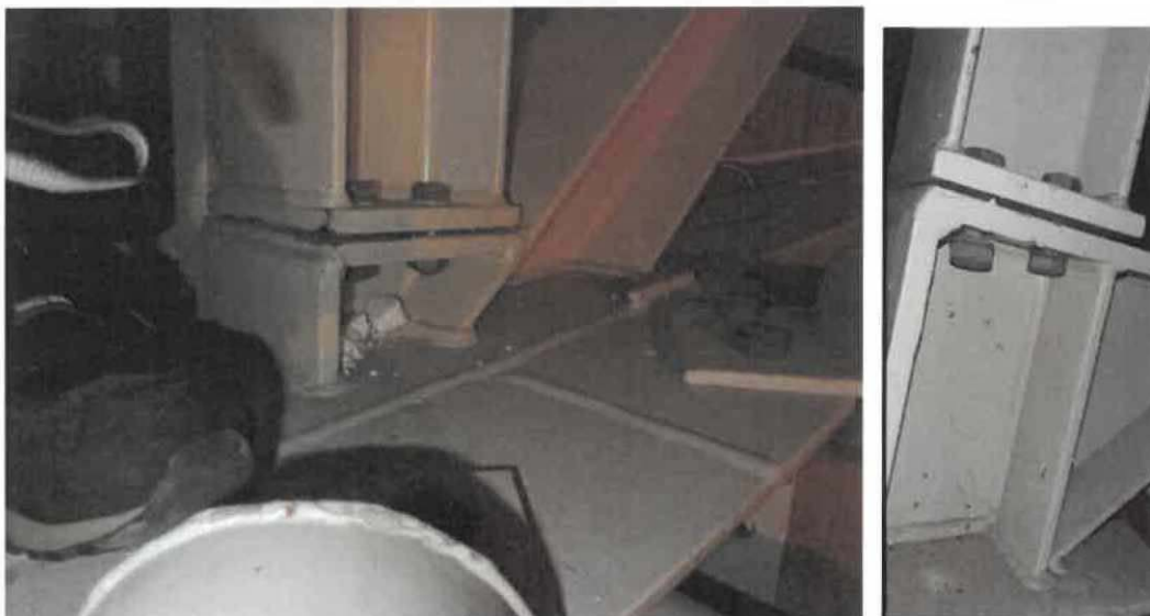
OBR: 10, 11, 12, 13 – Volné šrouby a rozevřená příruba svislice a spodního pasu – BEZE ZMĚNY OD MINULÉ KONTROLY
