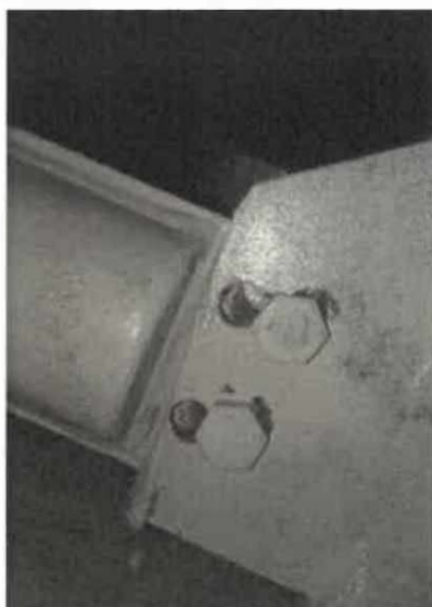
OBR: 05, 06A, 06B, 07 – Dlouhé otvory v přípojích výpletu
