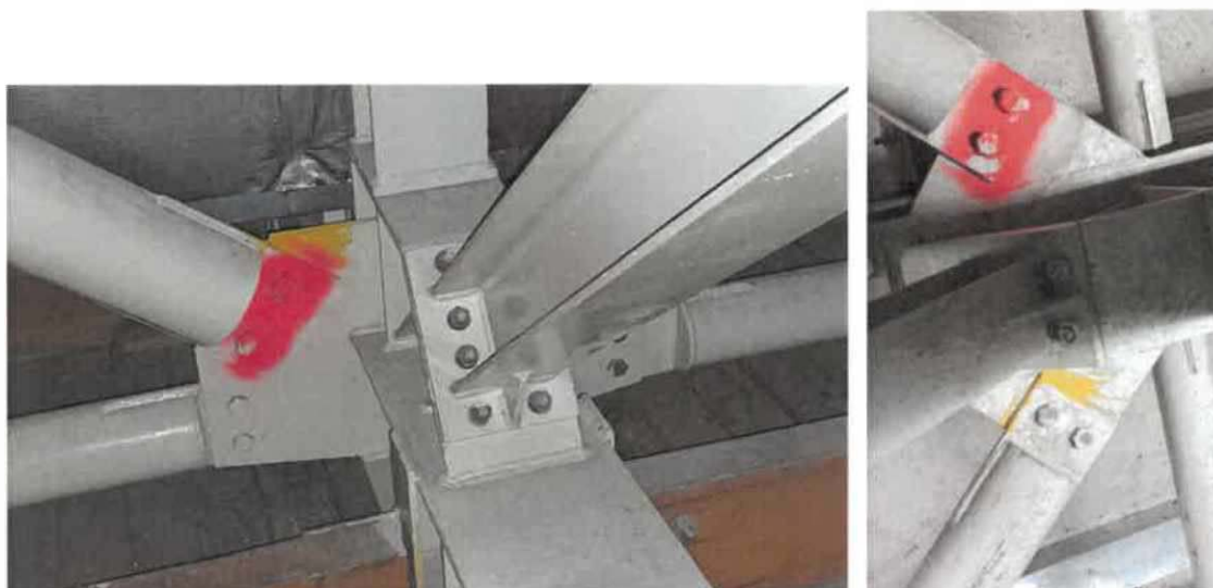
OBR: A, B – Označené a dotažené šrouby
