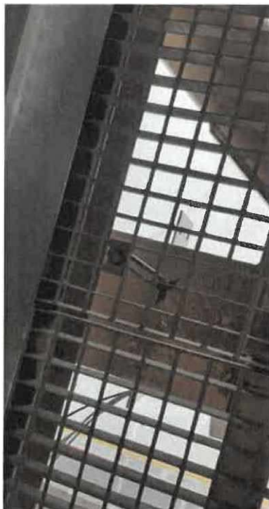
OBR: 24 – Uvolněné přichytky pororoštu – 07 / 2021
