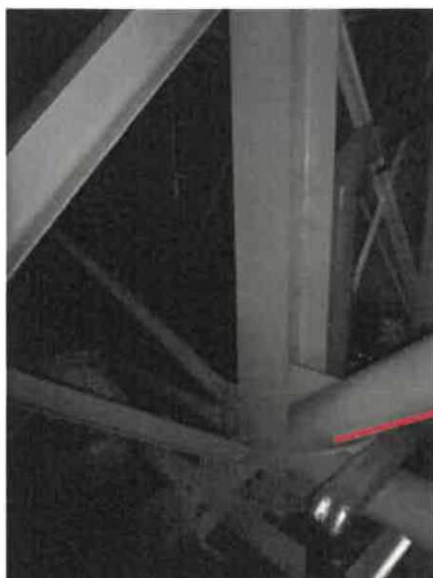
OBR: 08, 09 – Všechny volné šrouby v přípojích – BEZE ZMĚNY OD MINULÉ KONTROLY
