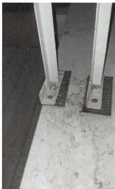
OBR: F – Vyosená podpora potrubí VZT – 04 / 2023
