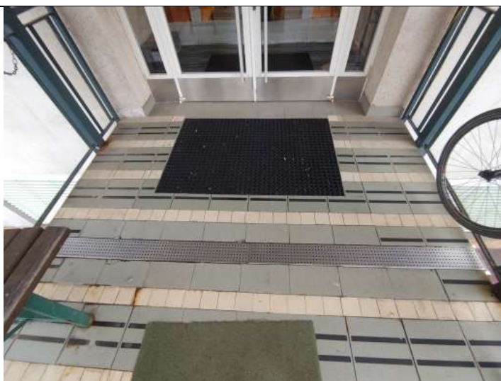
STÁVAJÍCÍ ČISTÍCÍ ZÓNA
