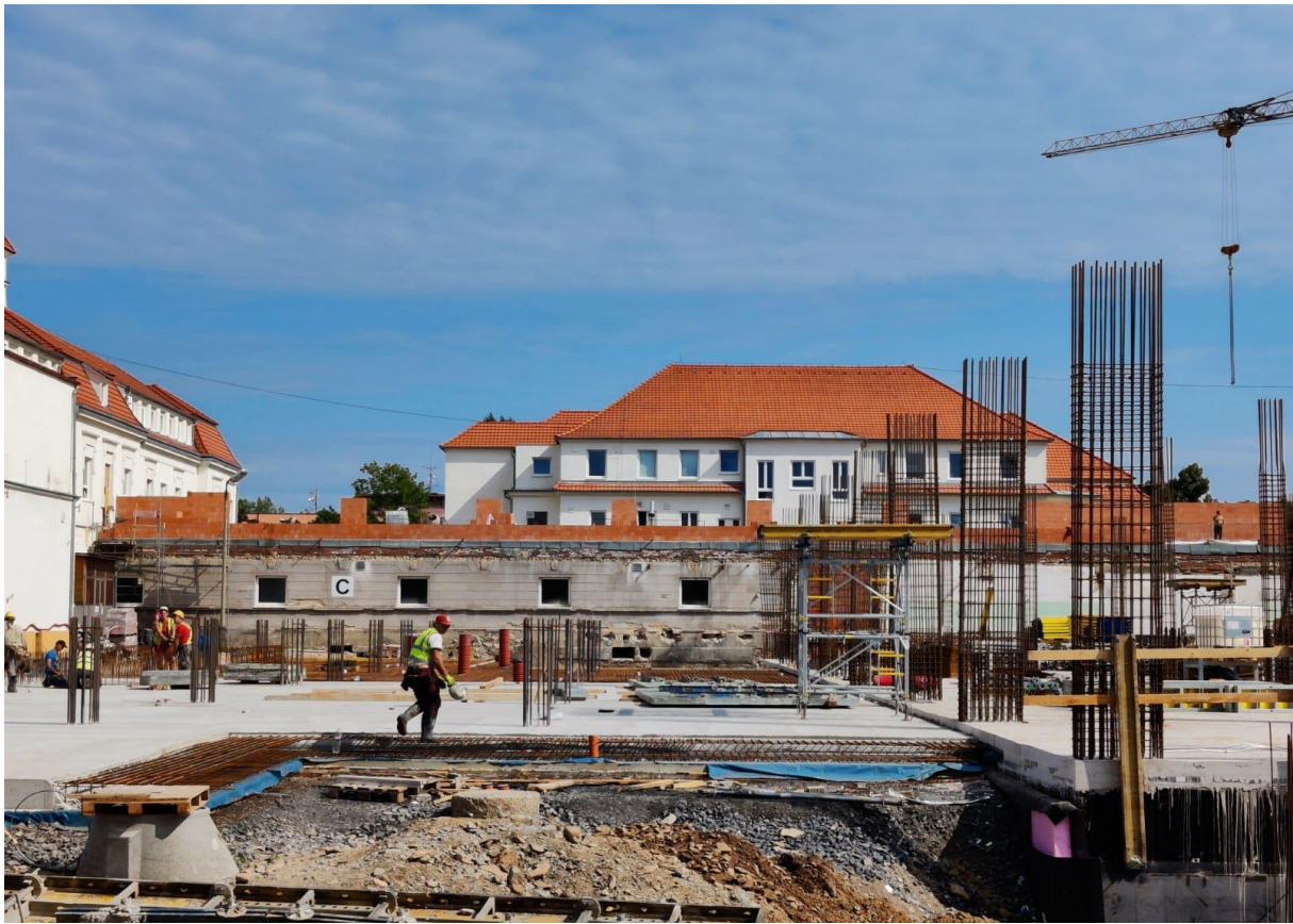
Fotografie z probíhající výstavby:
