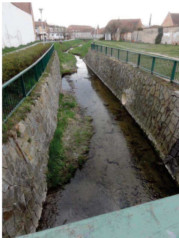
Pohled na zábradlí pod výtokem ze zaklenutí křižovatky
