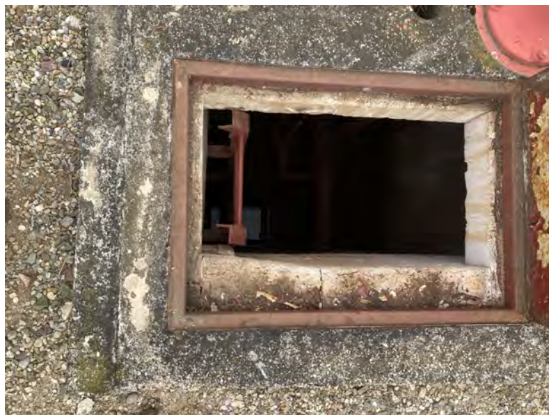
Stávající hydrant – vstup do šachy a poklop
