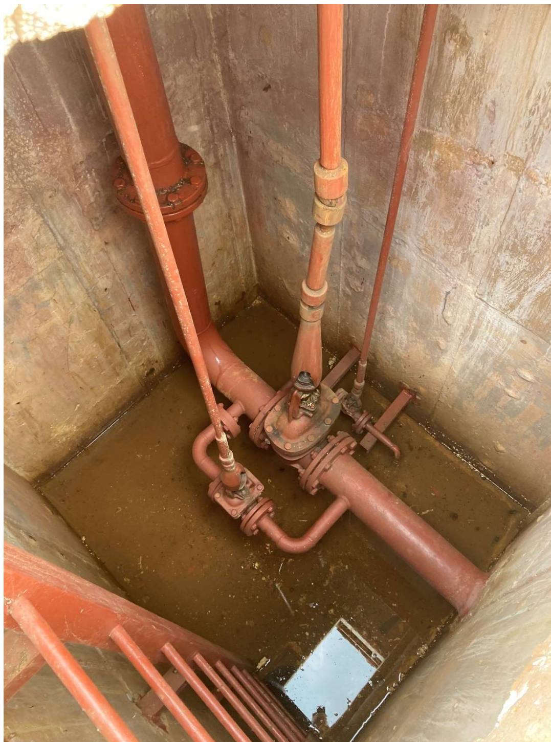
Stávající hydrant - podzemní část
