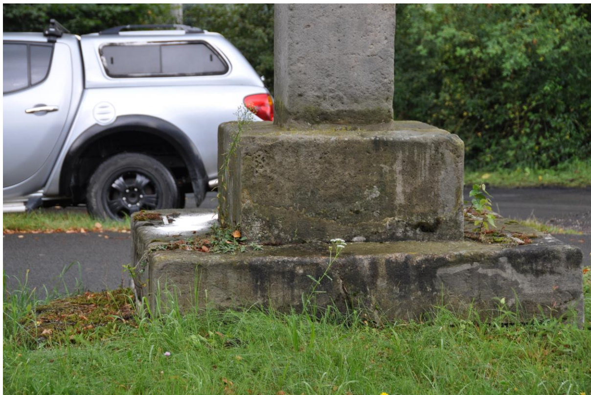
Obrázek 10 - Detail biologického napadení a znečištěním typickým pro použití hydrofobizace
