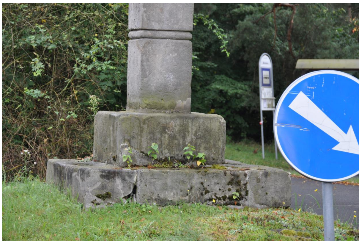
Obrázek 11- Detail biologického napadení a znečištěním typickým pro použití hydrofobizace, úbytky hmoty pískovce a dožilé tmely
