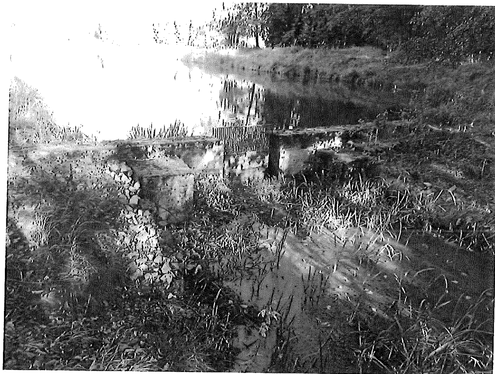
Obr. 3 – vyústění dřevěného odpadního potrubí od požeráku
