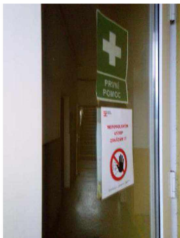
Nedostatek 1: Vstupní dveře do dopravní kanceláře bez označení „Zde hlaste požár!“
