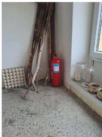
Nedostatek 3: Nezajištěný hasicí přístroj v 3 NP. Stížená průchodnost zásahové cesty do půdních prostor.
