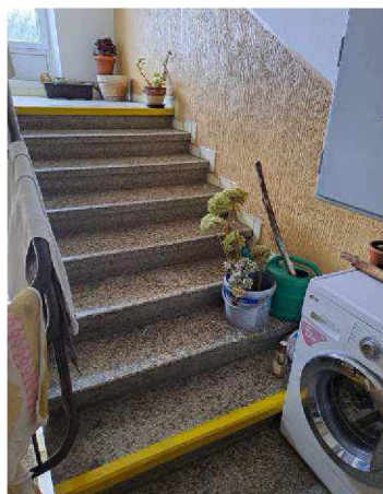
Nedostatek 3: Nezajištěný hasicí přístroj v 3 NP. Stížená průchodnost zásahové cesty do půdních prostor.
