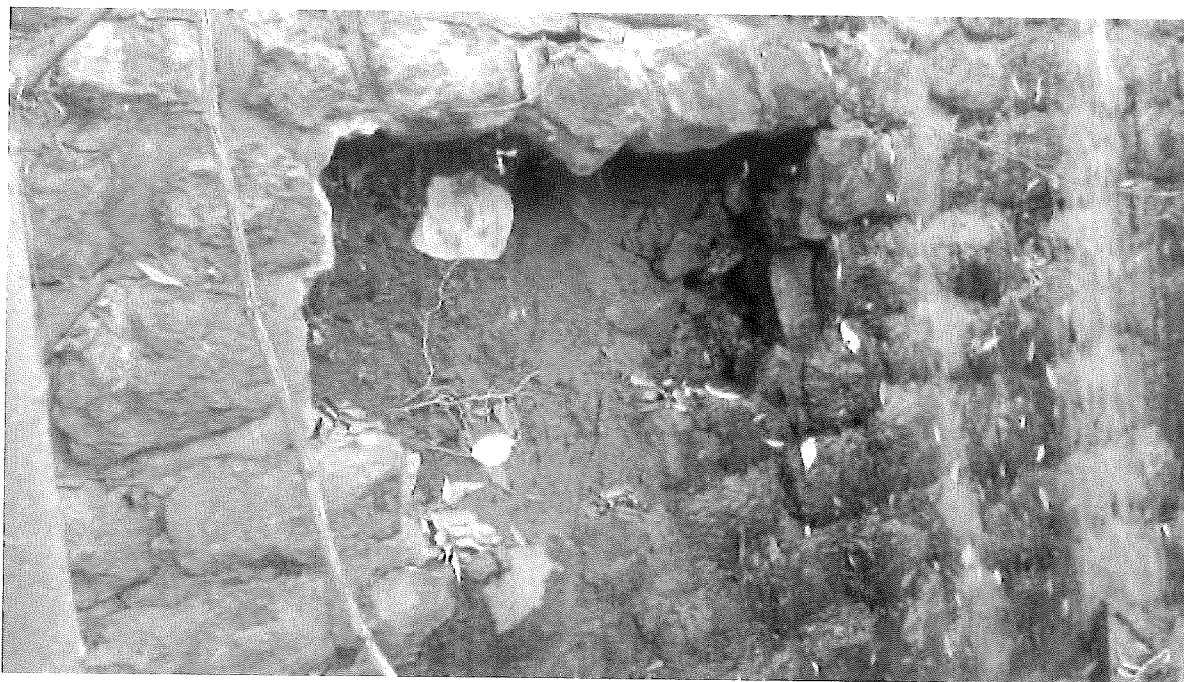
Obr. č. 5: Pohled na vypadávající kameny z tělesa stupně v ř. km 2,080 VT PP Dyje
