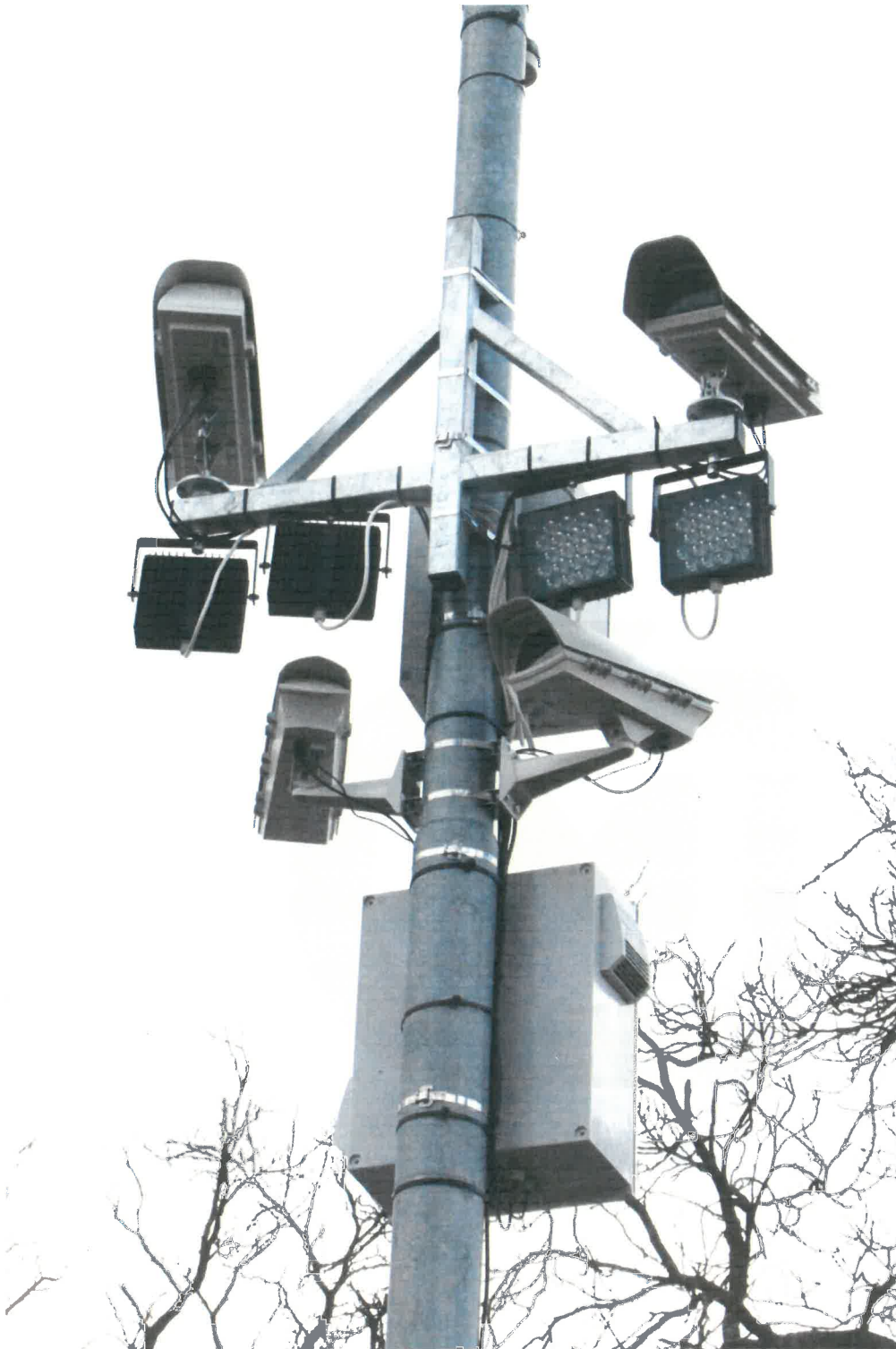
Obr. 5 Umístění kamer, detektoru přítomnosti vozidla a výpočetní jednotky na sloupu
