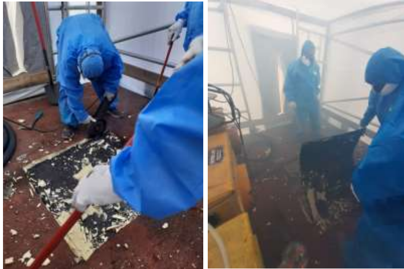
Demontáž střešních vrstev
