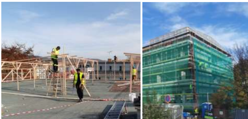
Konstrukce Kontrolovaného pásma pro odstranění azbestu
