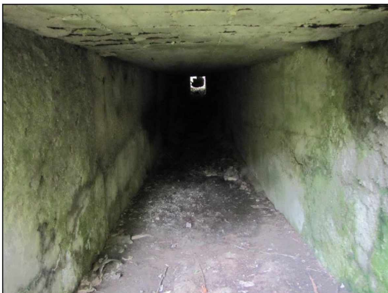
Pohled dovnitř od pravého čela
