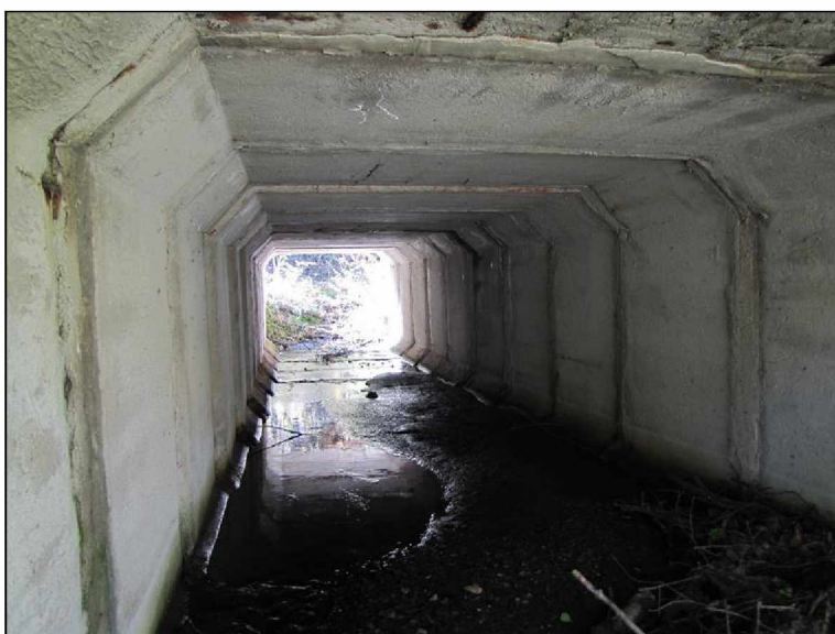
Pohled dovnitř od levého čela
