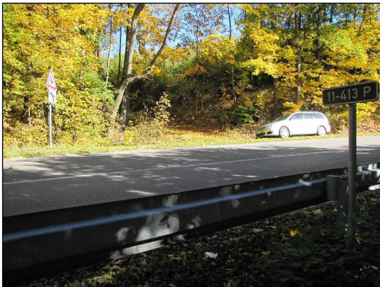
Označení propustku vpravo
