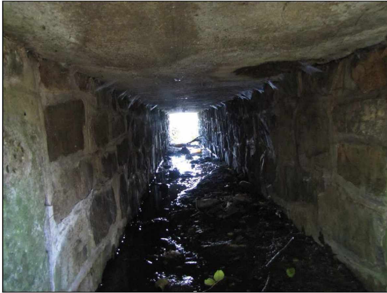
Pohled dovnitř od levého čela
