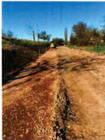
Pokládka ŠD 0/63 v místě chodníku
