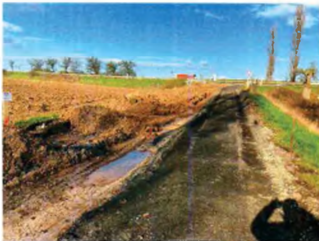
Vybourání betonové KCE
