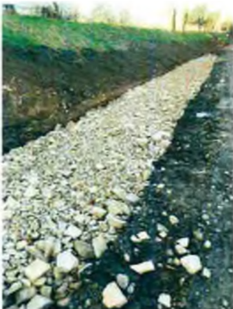
Sanace chodníku HDK
