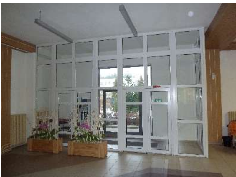
Okna:komplet stěna Počet:komplet stěna Rozměr: 560 x 297
