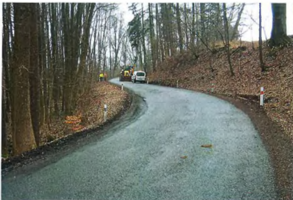
Silnice III / 3036, v pozadí sondážní práce na sondě B-2
