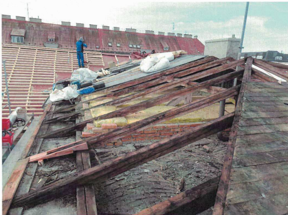
Budova SO 01 – impregnace krovu
