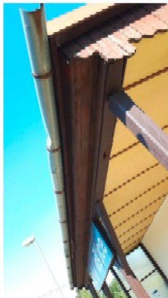
Obr. 2 – Oprava klem. Prvků
