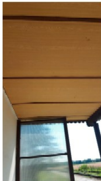
Obr. 3 – Oprava podhledu.
