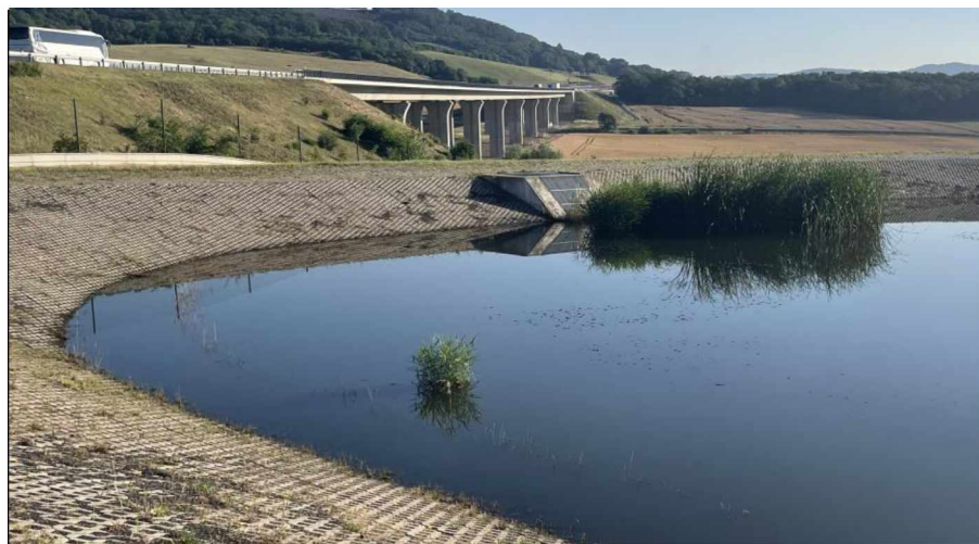
fotografii pořizovat z vnitřního svahu RN směrem na čelo a bok VO
