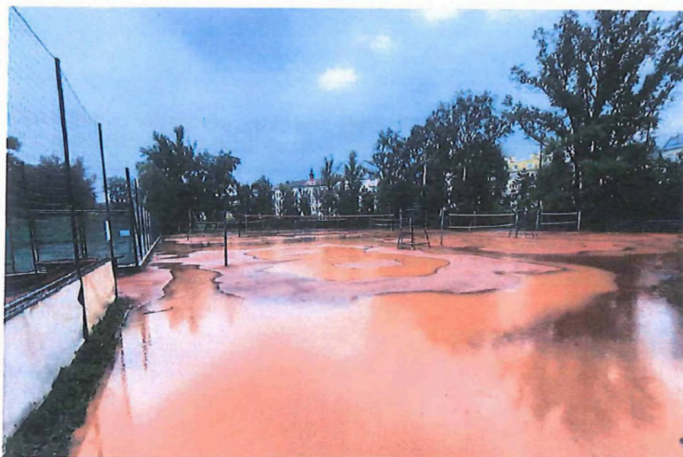
Obr.2 – Stav plochy kurtů po vydatnějším dešti
