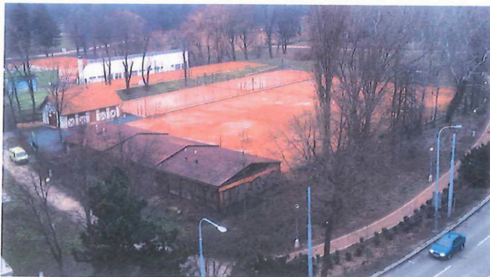
Obr.1 – Celkový pohled na areál
