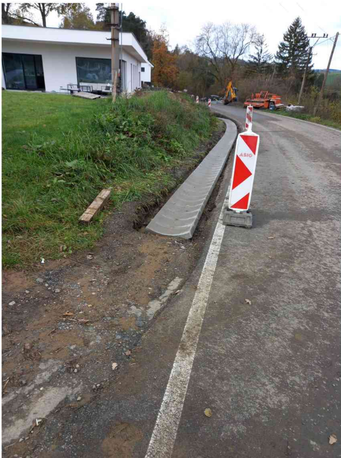
Obrázek 3 – odvodňovací příkop ze žlabových tvárnic
