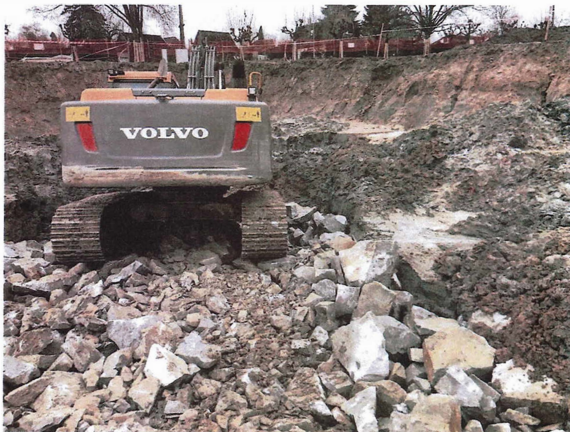
Fotodokumentace v rámci ZI č 2. – Úprava/výměna podloží pod základovou deskou
