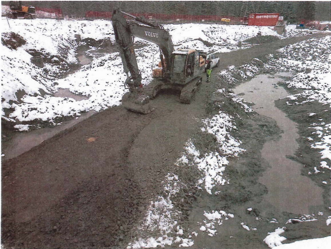
Fotodokumentace v rámci ZL č 2. – Úprava/výměna podloží pod základovou deskou
